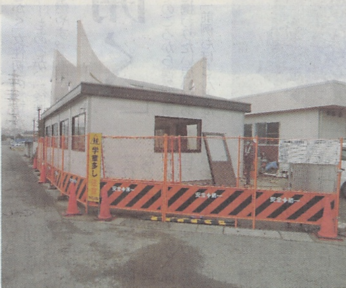
仮設教室の設置を進めている市立中新田保育園 ＝海老名市中新田
